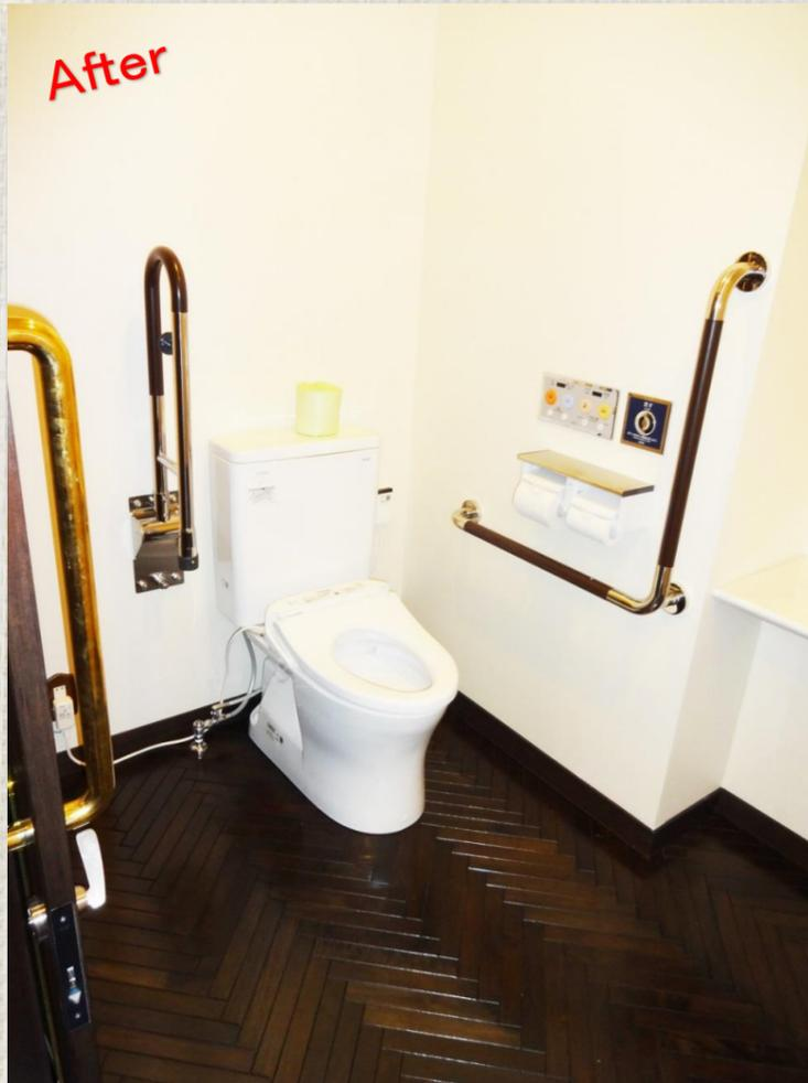
広さも十分な新設車椅子用トイレ。L型手すりと跳ね上げ手すりを付け、カウンター手洗い器も取付けました
